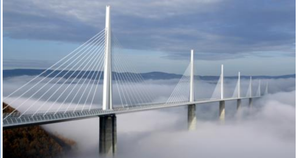
Grande Viaduc de Millau - ein Bauwerk der Superlative. Die 2460 Meter lange Schrägseilbrücke im Süden des französischen Zentralmassivs westlich der Stadt Millau und ist die höchste Autobahnbrücke der Welt. (Quelle: http://www.zdf.de/ZDFmediathek/beitrag/bilderserie/112560/Moderne-Bruecken-Konstruktionen/#beitrag/bilderserie/112560/Moderne-Bruecken-Konstruktionen )
